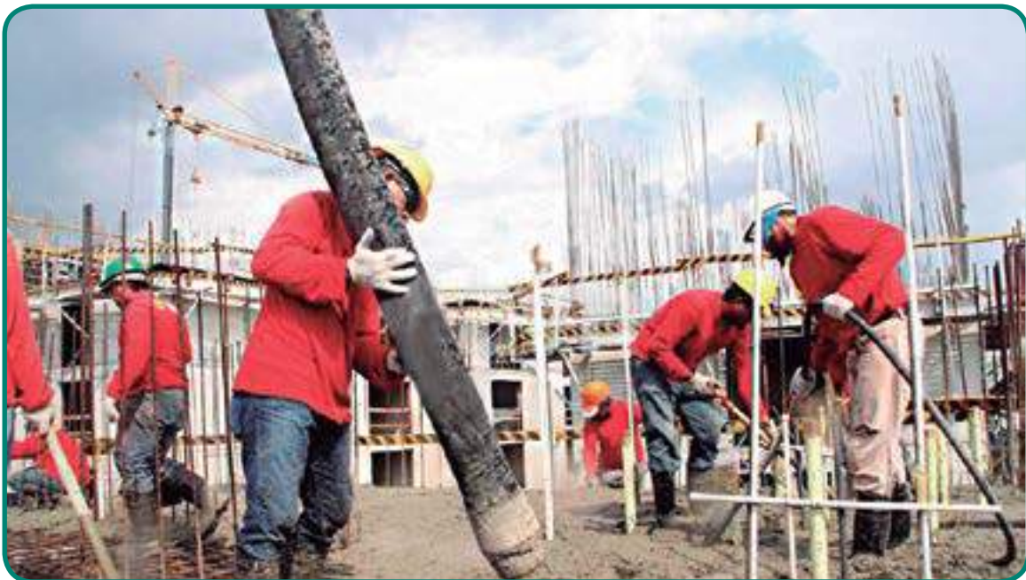
Construcción de viviendas multifamiliares. Fuente: www.albaciudad.org
