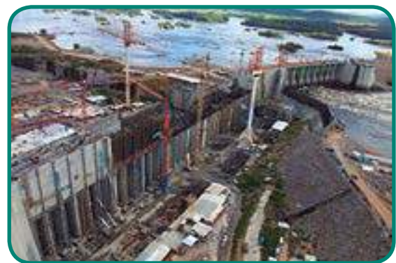
Manuel Piar (Tocoma, actualmente en construcción)
