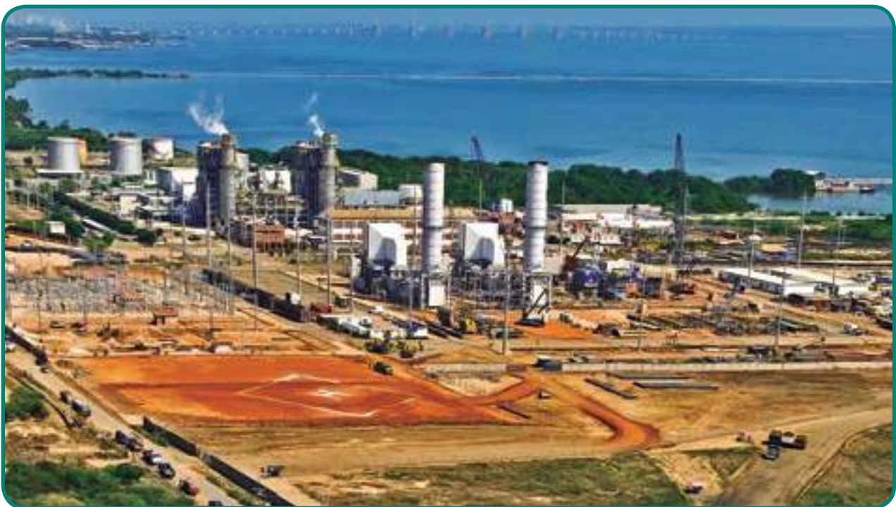
Central termoeléctrica. Fuente: Corpolec (2012).
