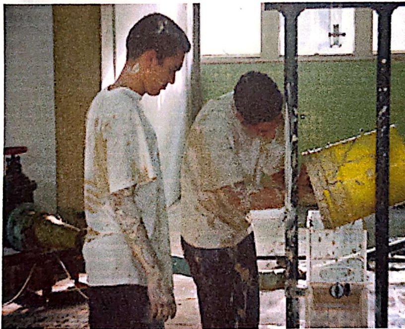
Alan y Guillermo vertiendo la mezcla en el deposito del canal
